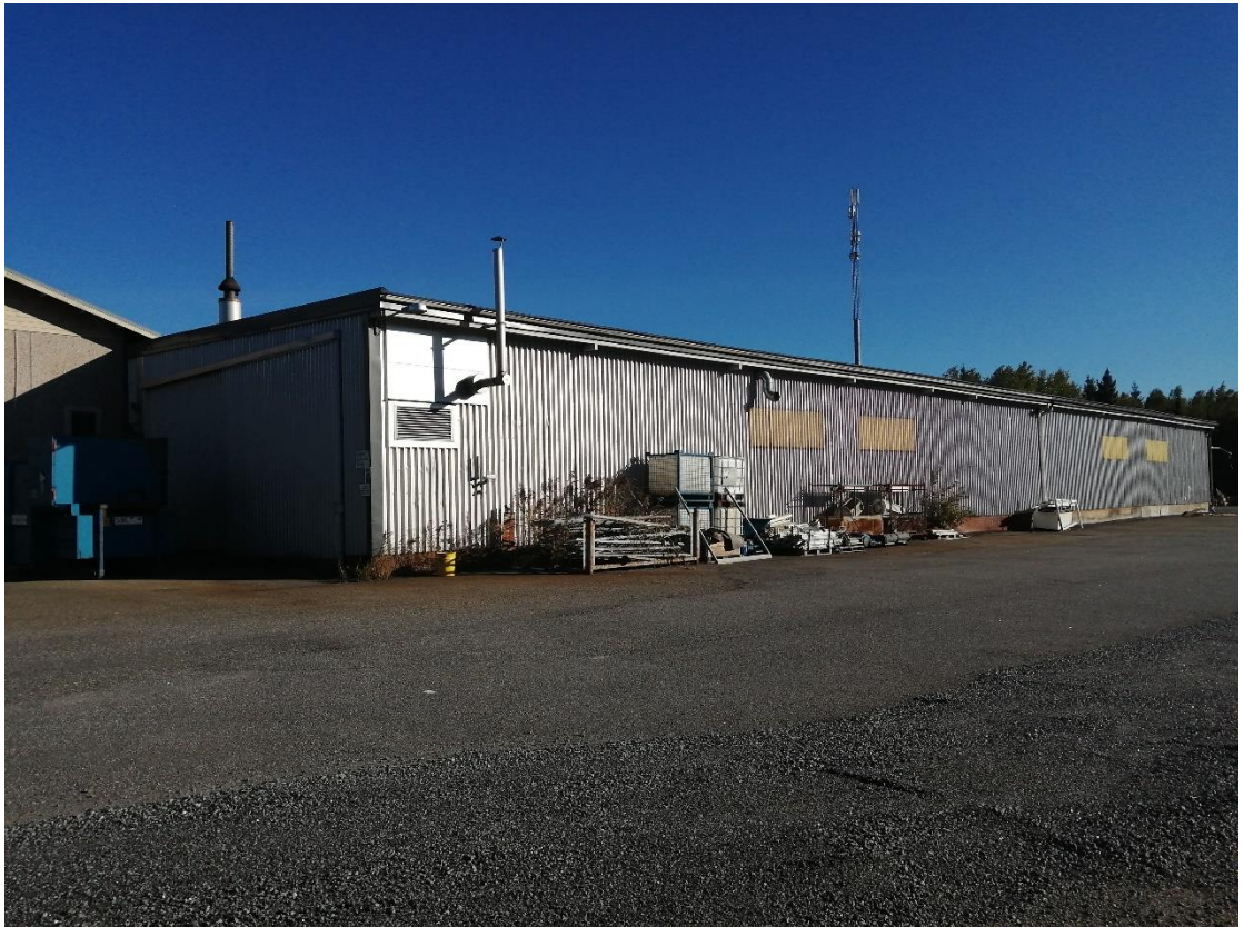
Kuva 4. Teollisuusrakennuksen eteläisimmän osan julkisivumateriaalina on pelti. Vuokra-alueen raja käytännössä sivuaa rakennusta.
