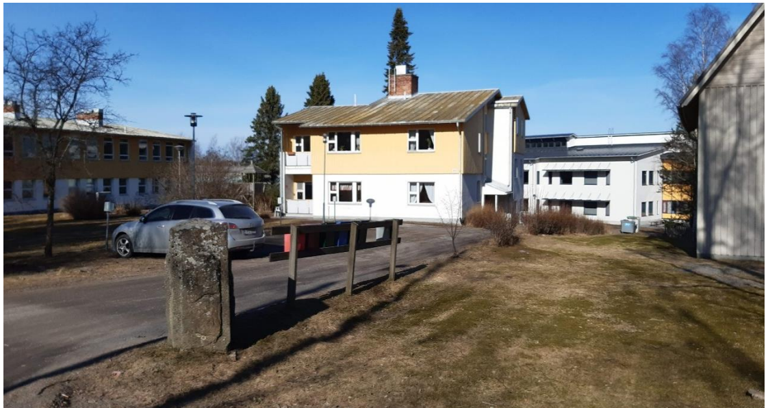
Kuva 3. Kortteli 14a. Kerrostalotontti (AK) keskellä, koulutontin (YO-1) vanha rakennus vasemmalla ja koulun uusi osa takana. Kuvattu Sulvantieltä.
