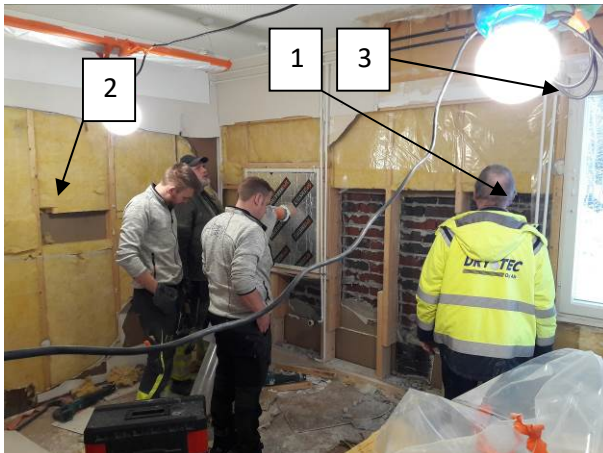
Kuva 9. Huone 4 helmikuun alussa. Kohdat, joista otettiin materiaalinäytteet, on merkitty kuvaan.
