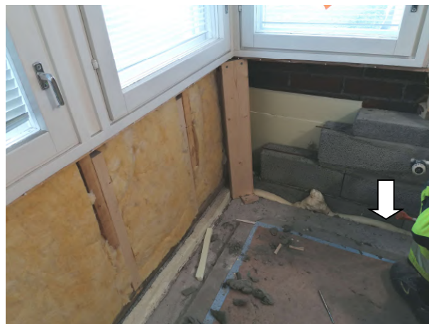
Kuva 33. Ulkokulma huoneessa 4. Vasemmalla vanha purkamaton seinä ja oikealla jälleenrakennusvaiheessa oleva seinä. Lecan ja lattiavalun väli tiivistetty 2-komponenttiuretaanilla (nuoli).
