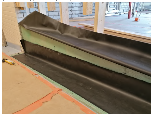
Kuva 39. Rampin väliseinän (huoneet 10/11) syvennys valettiin umpeen betonilla. Valun pinta käsiteltiin Florosil TS ja primerillä, ja päälle asennettiin limittäinen radonkermi.
