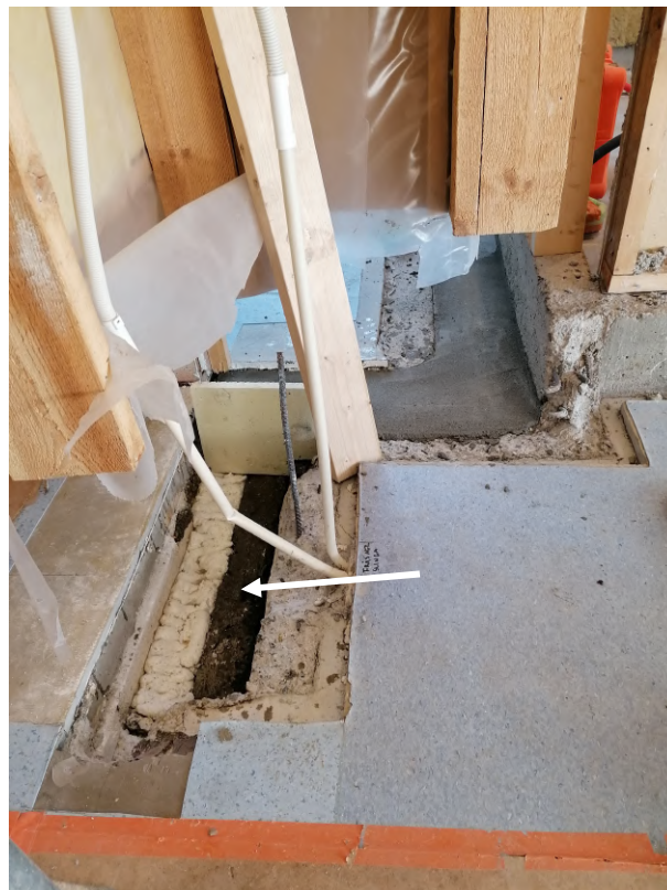
Kuva 37. Huone 6. Vanhan, väliseinän olleen, ulkoseinän alaosan saneerausvaiheet ovat samanlaiset kuin ulkoseinien. Nuoli osoittaa nostovalua, joka käsitelty Florosil TS-aineella. Lattian ja valun väli täytetty 2-komponentti-uretaanilla. Tämän päälle valetaan kerros betonia (tulos näkyy taaempänä).
