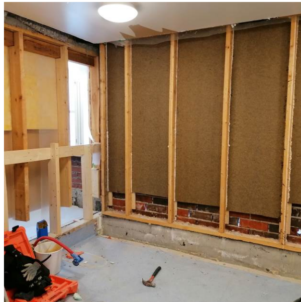
Kuva 41. Huone 6. Päiväkodin eteisen WC. Ulkoseinä purettiin yläpohjaan asti. Uusi tuulensuojalevy asennettu osittain.
