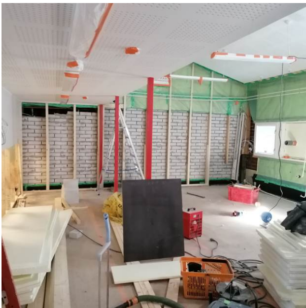
Kuva 46. Huone 11. Kuvassa näkyvien ulko- ja väliseinien alaosat ovat valmiit. Radonsulku molemmissa.
