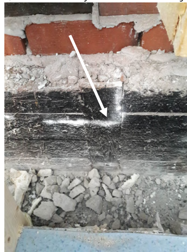
Kuva 20. Huone 4. Väliseinien alaosat on purettu 1,5 m asti. Näkymä huoneisiin 2 ja 3.
