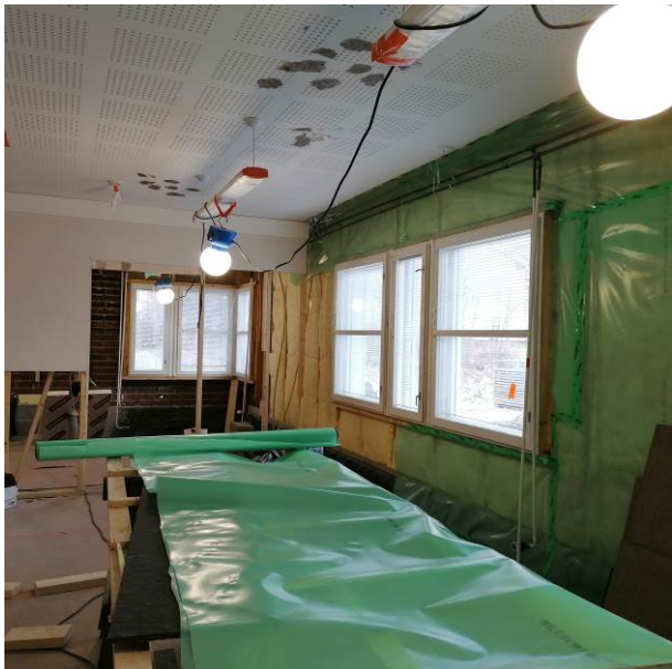
Kuva 48. Huoneen 10 ulkoseinä, jossa korjattu alaosa, uudet eristeet ja osittain höyrynsulku asennettu. Edessä huone 4.
