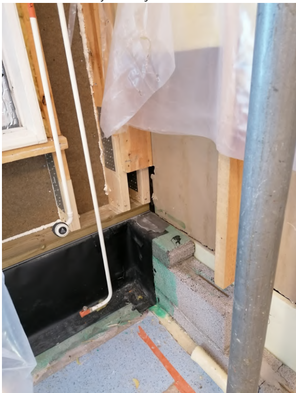
Kuva 34. Huone 14, varaston puoleinen kulma. Radonkermi kiinnitetään bitumilliimalla. Pinnassa primeri.
