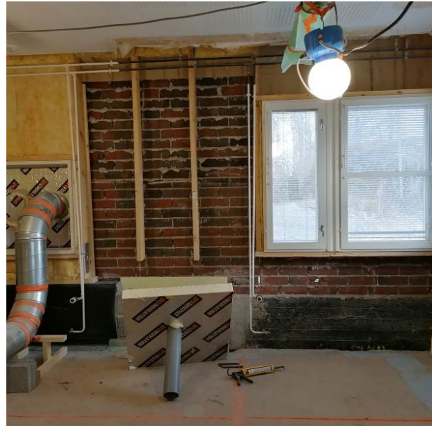
Kuva 45. Huone 4. Vasemmalla näkyy valmistunut seinän alaosa (radonsulku päällimmäisenä), ja oikealla vielä jyrsimätön sokkelipinta.
