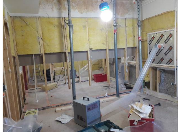
Kuva 20. Huone 4. Väliseinien alaosat on purettu 1,5 m asti. Näkymä huoneisiin 2 ja 3.
