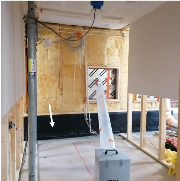
Kuva 44. Huone 3. Ulkoseinän radonsulku on paikoillaan (nuoli) ja uudet eristeet seinässä.
