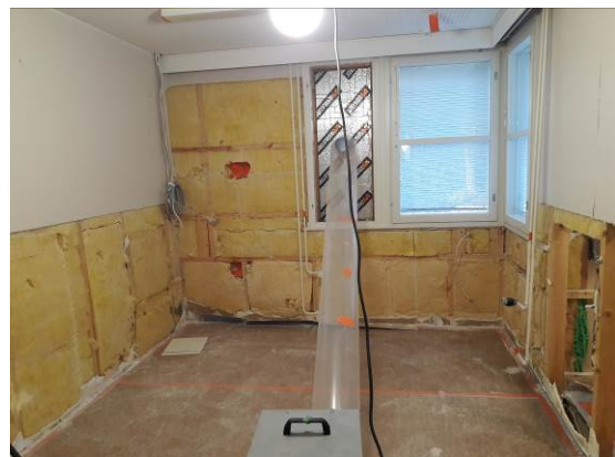
Kuva 24. Huone 2. Vuonna 2018 tutkimuksen aikana tehdyt näytteidenotot ulkoseinästä näkyvät oransseina kohtina.
