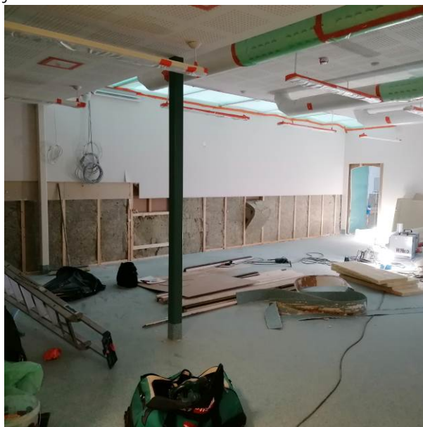
Kuva 51. Huone 33, eli ruokasali. Väliseinä käytävälle ja käynti huoneeseen 32. Alkuperäinen eriste.
