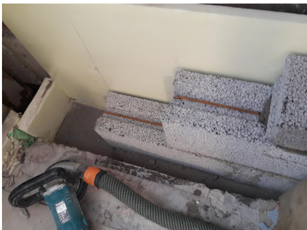
Kuva 32. Ulkoseinä huoneessa 4. Purun jälkeen seinän alaosaan tehtiin betonivalu, jotta saataisi tasainen ja tiivis alusta jälleenrakennukselle. Betonin pinta käsiteltiin Florosil TS kosteus- ja emissiosululla. 2,5 Leca-harkkoa valun päällä ja 50 mm Finnfoam-levy Lecan ja sokkelin välissä.
