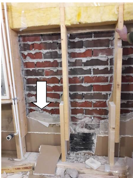
Kuva 9. Huone 4 helmikuun alussa. Kohdat, joista otettiin materiaalinäytteet, on merkitty kuvaan.
