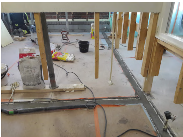
Kuva 38. Huoneiden 3, 4 ja 10 väliseinät. Vanha materiaali poistettiin, syvennys puhdistettiin ja valettiin umpeen betonilla. Betonin pinta käsiteltiin kosteus- ja emissiosululla.
