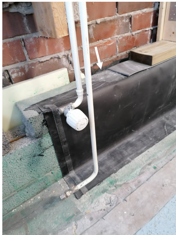
Kuva 35. Huoneen 10 ulkoseinä. Vedeneristys tiivistää radonkermin ja tiilimuurauksen välin (nuoli). Alajuoksun alle tulee neopreenikaistale.
