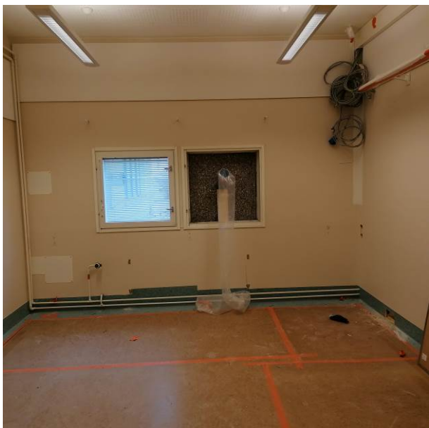
Kuva 50. Huone 19. Huoneisiin 18 ja 19 ei olla tehty vielä toimenpiteitä. Ulkoseinät tullaan purkamaan ylös asti. Huoneiden välillä on kevyt väliseinä betonilaatan päällä.
