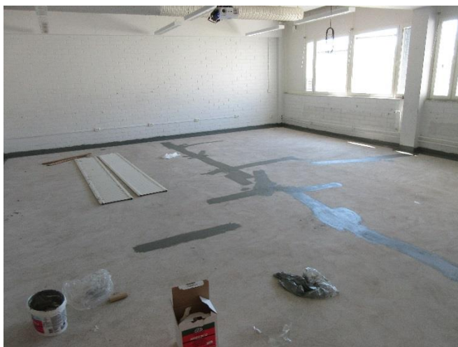
Bild 1. Täthetsreparation under arbete. Golvytan avlägsnades i flera utrymmen och sprickor samt anslutningar tätades.
