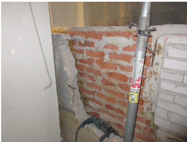
Bild 7. Gammalt murat skal (både inre och yttre) samt isolering avlägsnades. Ytor rengjordes mekaniskt innan återbyggnad.
