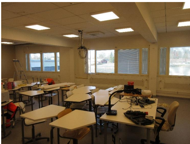
Bild 14. Färdigställnings av täthetsreparation.
