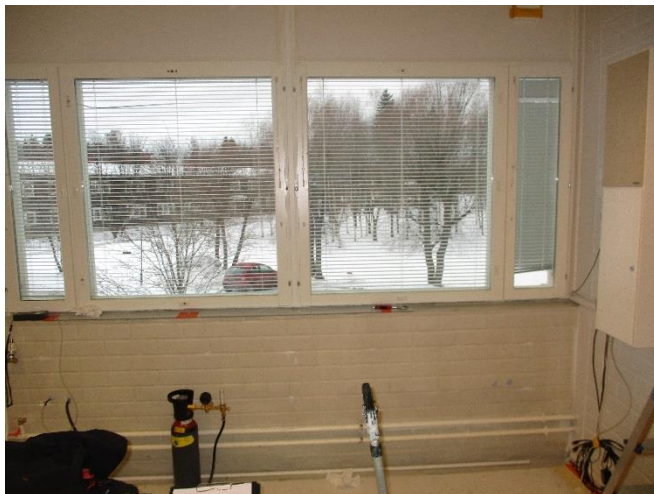
Bild 15. NÖ7. Spårgastest av yttervägg. Ifall läckageplatser hittades tätades dessa tills gas ej mera läckte in.
