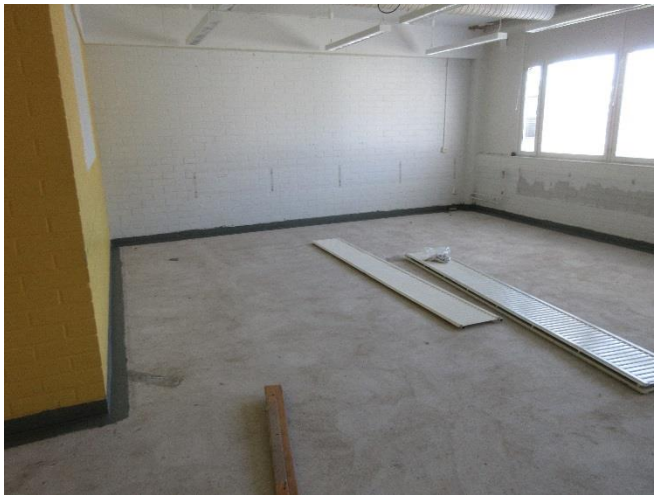
Bild 2. Täthetsreparation under arbete.
