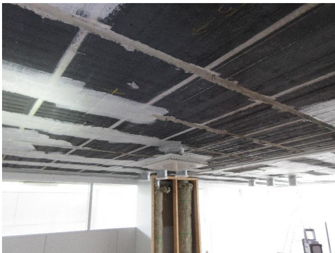
Bild 17. Täthetsreparation av tak i SÖ10.
